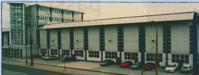
Die moderne Fertigungshalle, welche zu Treuhandzeiten Anfang der 90er-Jahre gebaut wurde.
